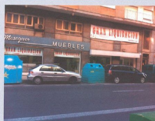
VISTA FACHADA VICENTE BLASCO IBAÑEZ
